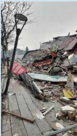
Links: Die vom Erdbeben zerstörte Bildungseinrichtung in Antakya
